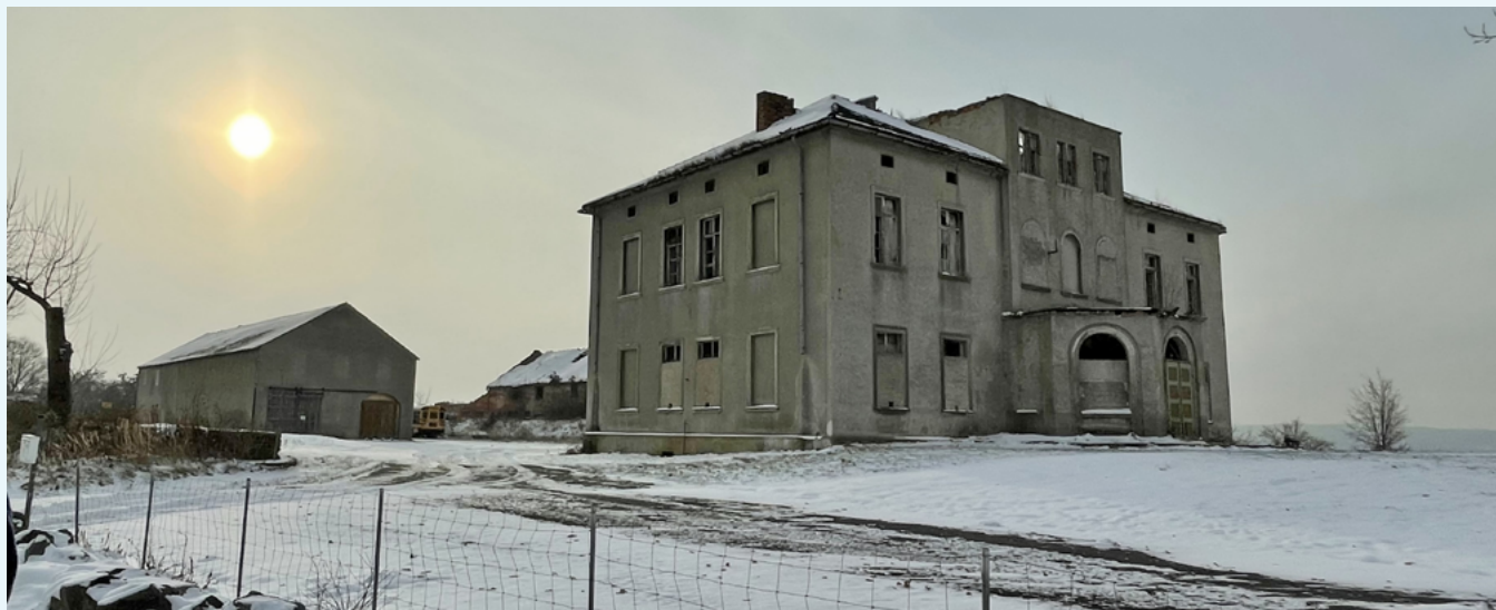
Das ehemalige Gutshaus des Oberhofes in Deutsch Ossig (DNK ©Dr. Ulrike Wendland)
